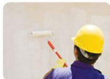
5. Aplicar Selador (uma ou duas demãos)
