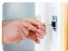
2. Proteger e Isolar (Tomadas, Janelas, Pisos)
