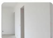
7. Massa Aplicada (pode-se aplicar outra demão Selador sobre a Massa corrida)
